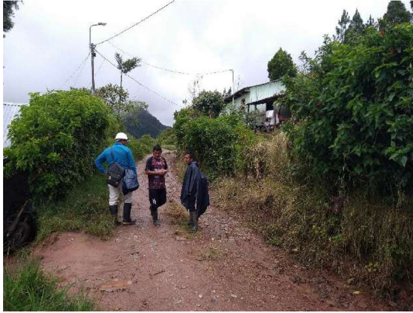
FIGURA 21. VIVIENDA 04 – HUAN 43 – AFECTACIÓN DE VIVIENDA.
