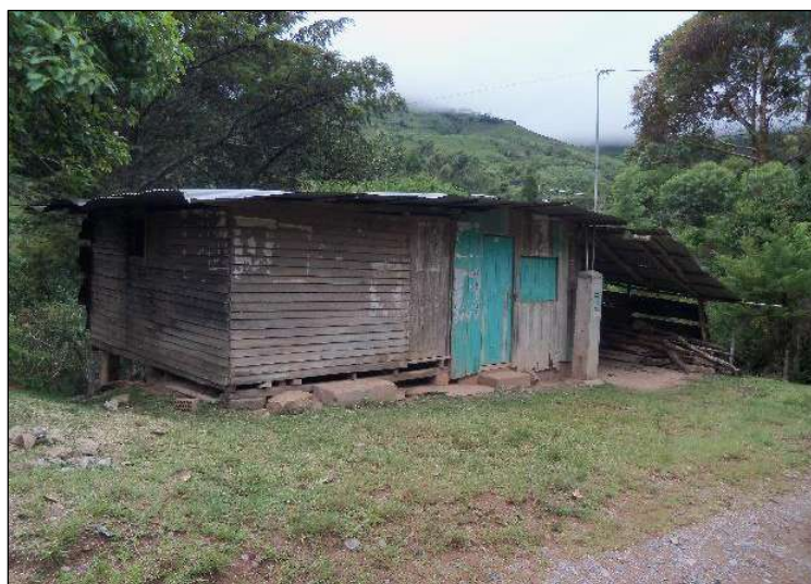
FIGURA 18. VIVIENDA 02 – HUAN 05 – AFECTACIÓN DE VIVIENDA.
