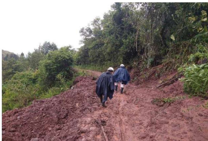
FIGURA 13. SECTOR 04 (8+220) CONTINUOS DERRUMBES.
