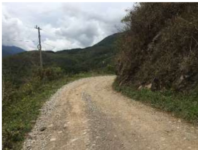
Ilustración 24: Vista del km 3+200.
