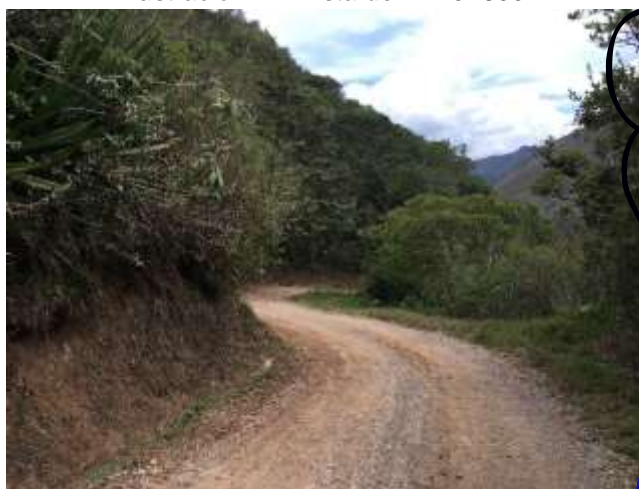
Ilustración 12: Vista del km 0+500.
