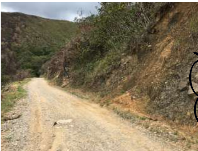
Ilustración 26: Vista del km 3+500.
