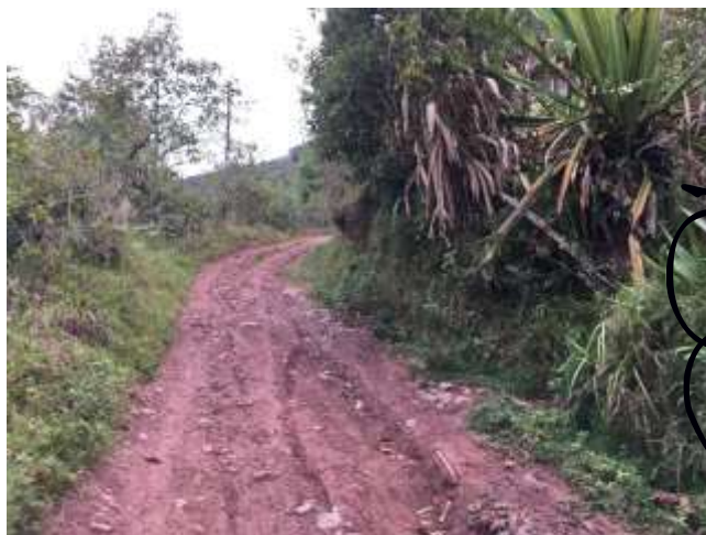
Ilustración 48: Vista de Final del km 9+680.
