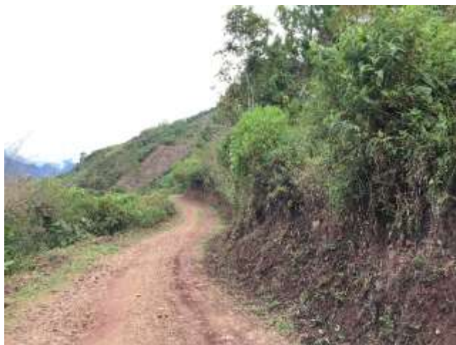
Ilustración 46: Vista del km 9+000.
