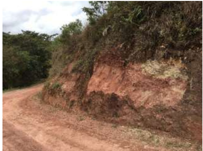
Ilustración 28: Vista del km 4+000.
