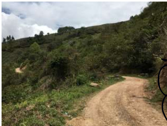
Ilustración 34: Vista del km 5+ 500.
