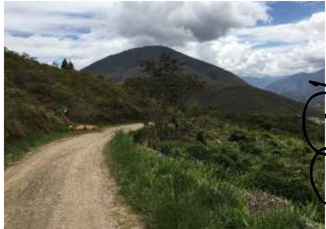
Ilustración 16: Vista del km 1+500.
