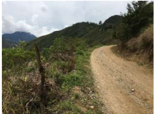
Ilustración 14: Vista del km 1+000.
