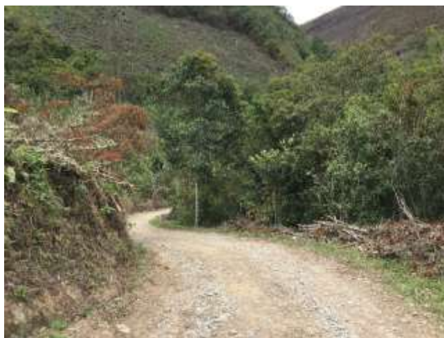
Ilustración 20: Vista del km 2+500.
