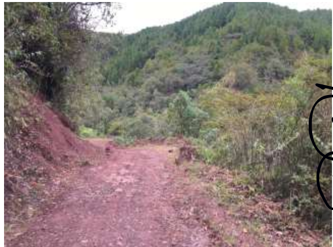
Ilustración 44: Vista del km 8+500.
