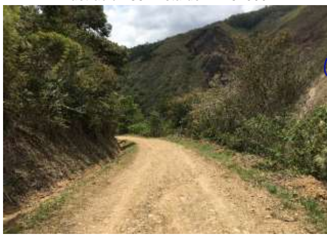
Ilustración 36: Vista del km 6+000.
