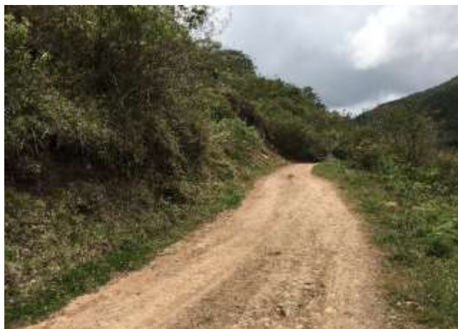
Ilustración 32: Vista del km 5+000.
