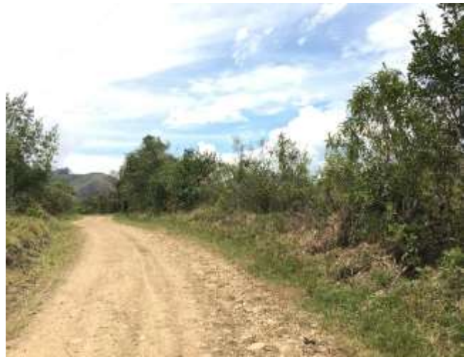
Ilustración 38: Vista del km 7+000.
