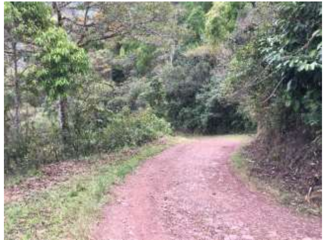
Ilustración 42: Vista del km 8+000.
