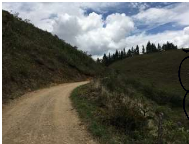
Ilustración 22: Vista del km, 3+000.
