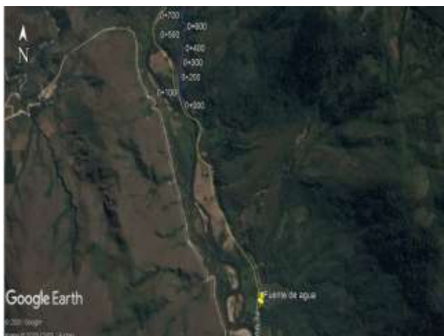
Ilustración 60: Vista satelital de la Fuente de Agua 02 Km 0+000.
