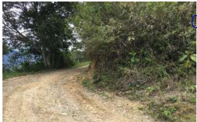
Ilustración 18: Vista del km 2+000.
