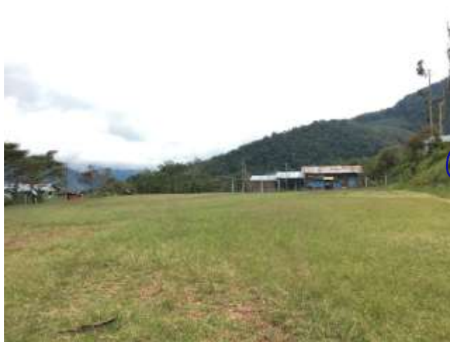
Ilustración 62: Vista del PM. En la Progresiva 9+500 km.
