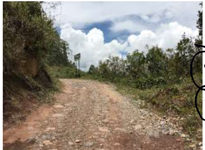
Ilustración 30: Vista del km 4+500.
