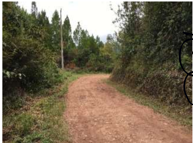
Ilustración 40: Vista del km 7+500.
